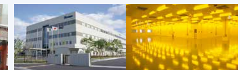
クリーンルーム完備のテクニカルセンター
